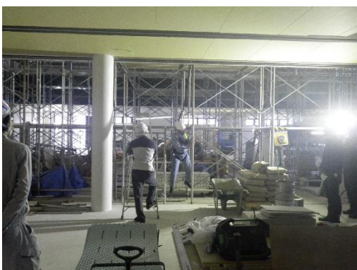
フルハーネス型安全帯について説明をする様子
