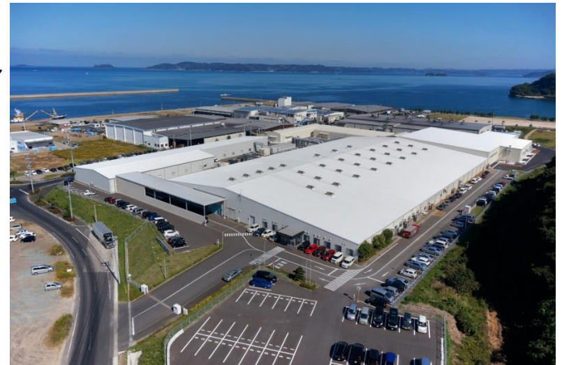
本社工場全景
