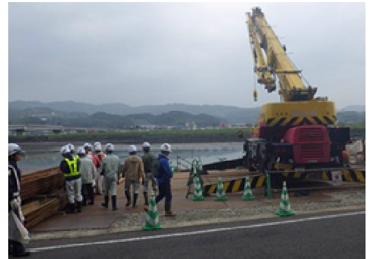
建設工事現場への実施指導状況
