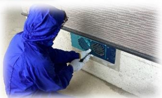
換気扇設置工事↓
