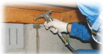
↑シロアリ防除工事
