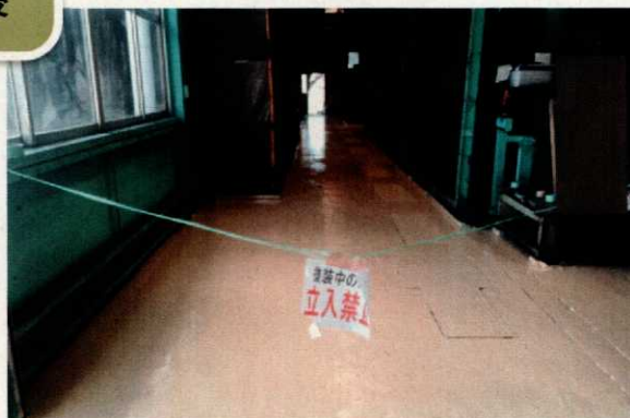
床面を明るいクリーム色に塗装した。
