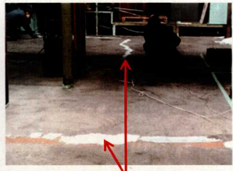
床面の塗装前には、床面の凹凸を塞ぐなど、転倒災害防止対策を講じた。
