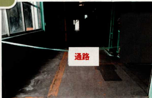
床面が暗く、凹凸及び汚れが目立たなかった。
