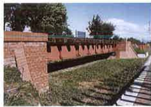
プレートガードー橋
