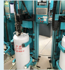
【LPガスボンベの充てん所の自動化】
