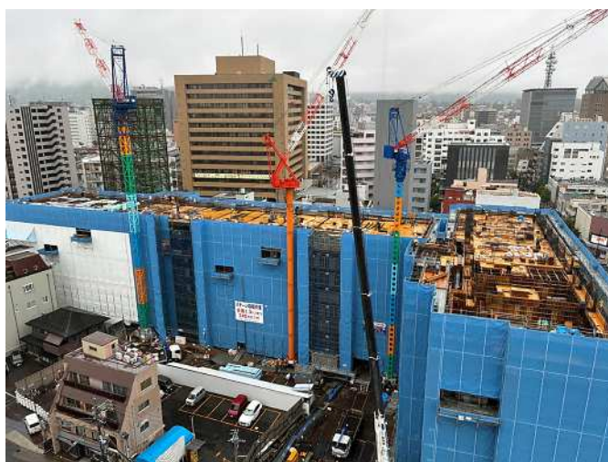
現場風景 (令和8年6月)
