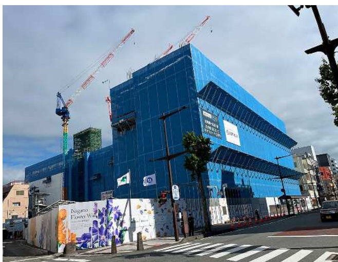
現場風景 (令和8年6月)
