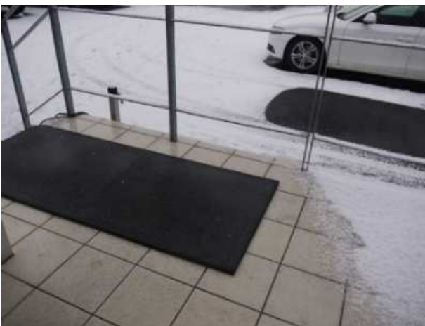
事務所出入口のヒートマットの設置例
