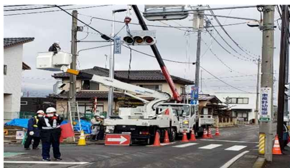
交通信号機工事に伴う片側交互通行誘導
