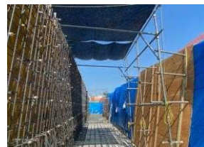
【写真 13.14】休憩場所を確保（一定の高さを確保して日よけとなる遮光ネットを設置）
