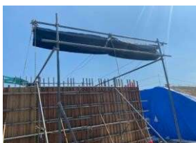
【写真 13.14】休憩場所を確保（一定の高さを確保して日よけとなる遮光ネットを設置）
