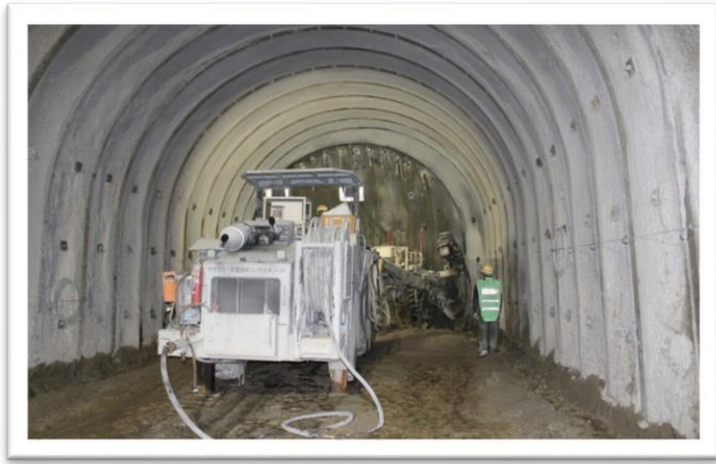
切羽での掘削作業を確認
