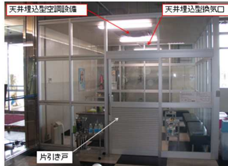
喫煙室設置後 (喫煙コーナーがあった屋内スペースに喫煙室を設置)
