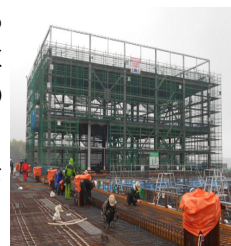
建設中の現場風景
