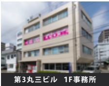
第3丸ビル 1F事務所
