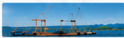
港湾・海岸工事
