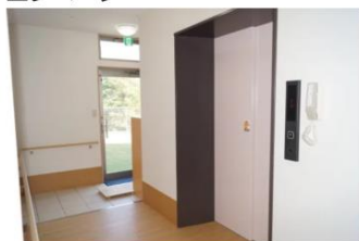
エレベーター
