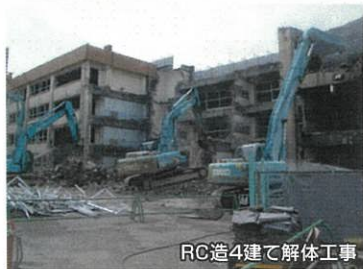
RC造4建て解体工事
