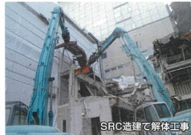
SRC造建て解体工事
