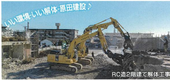
RC造2階建て解体工事
