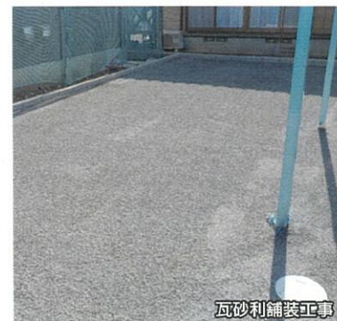
瓦砂利舗装工事
