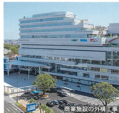
商業施設の外構工事
