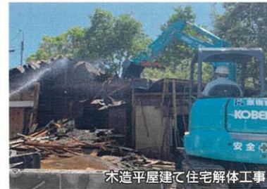
木造平屋建て住宅解体工事
