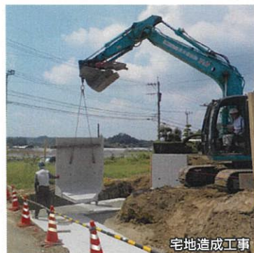
宅地造成工事
