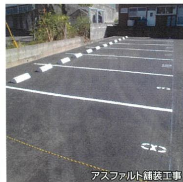
アスファルト舗装工事
