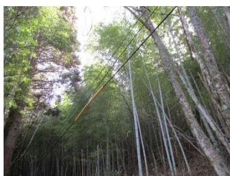
電力保安伐採とは、高圧・低圧配電線に接触、または近接（接近）している樹木を伐採する作業です。
