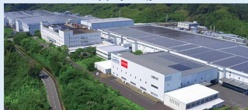
～宮崎第二工場～
