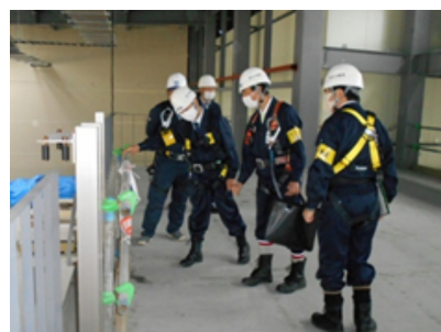
現場で墜落防止措置の状況を確認する田中局長(中央)
