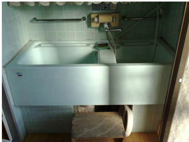
写真 2-9-3 踏み台を用意した浴槽
