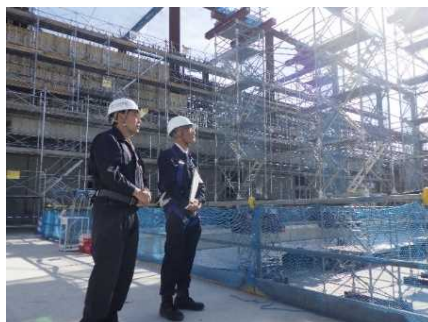
墜落防止措置の状況を確認する坂根局長（右）
