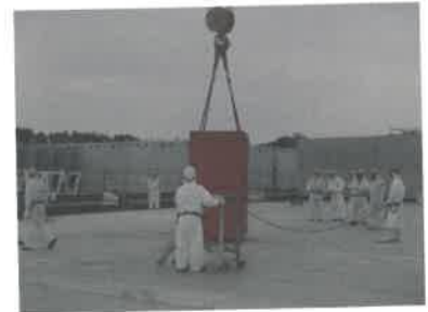
◆第一原発内クレーン検査
