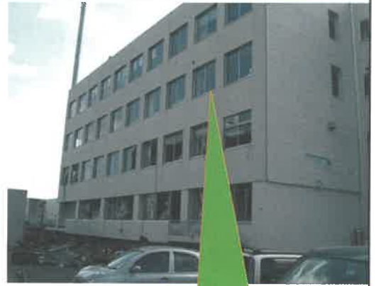
被災した合同庁舎 (3階が監督署)
