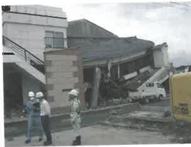
◆津波被害がれき処理工事現場指導
