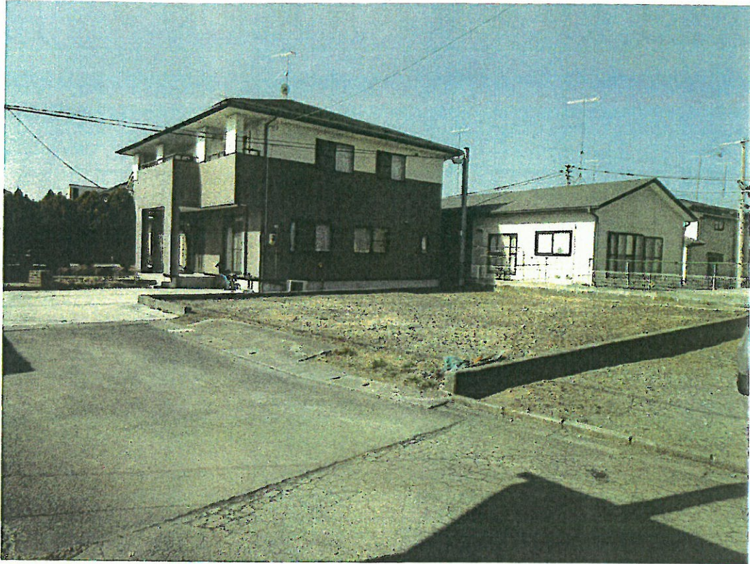
物件番号290101 現況写真
