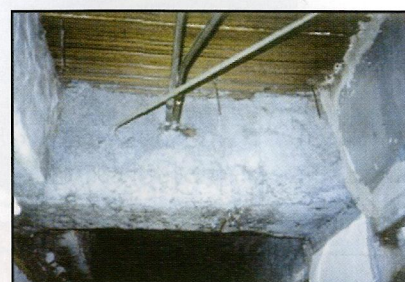
石綿による鉄骨の耐火被覆※12
