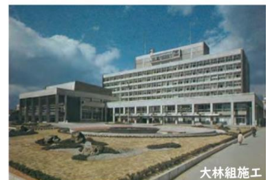
1965年(昭和40年) SRC造 コンクリート打放し(一部タイル張り) 構造体のコンクリートをそのままあわわして用いた端正な外観。 大林組施工
