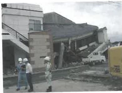
◆津波被害がれき処理工事現場指導
