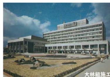
1965年(昭和40年) SRC造 コンクリート打放し(一部タイル張り) 構造体のコンクリートをそのままあらわして用いた端正な外観。 大林組施工
