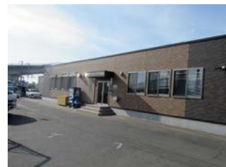
本社と作業所を統合した新社屋
