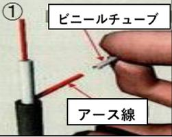
ビニールチューブ<br/>アース線<br/>①よじったアース線にチューブを挿入</p> <p>②
