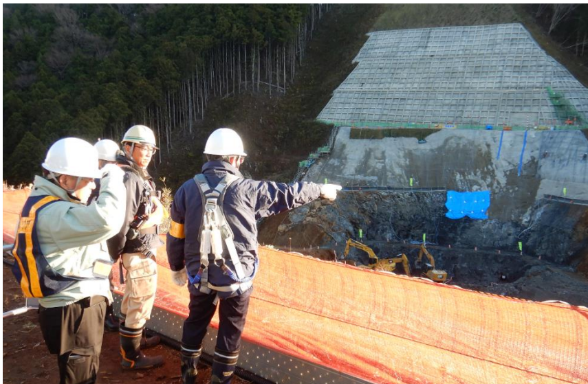
ダム的基础掘削について確認する竹内労働局長
