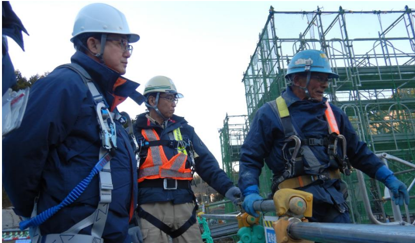
型枠作業の状況を確認する竹内労働局長
