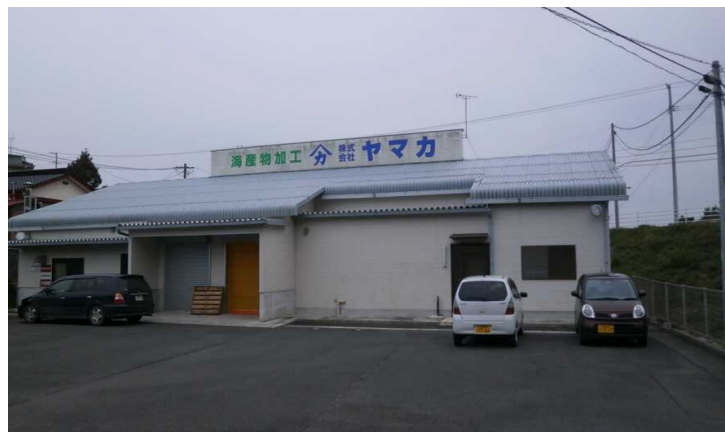
崎浜工場の外観です。こちらの工場ではわかめの食品加工が行われており、衛生管理を徹底している為、入室する為のチェックを厳しくしている工場です。
