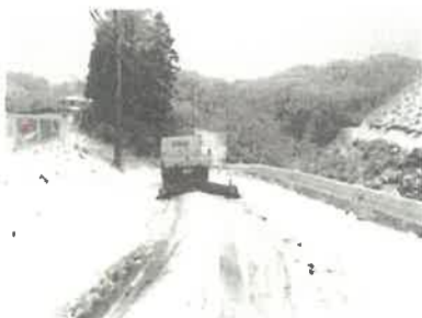
[降雪時には[地域貢献活動・緊急除雪工事]
