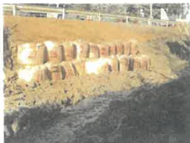
[緊急時にはく緊急対応工事]
