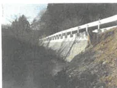
[大沢狼の巢線道路改良工事完成]
