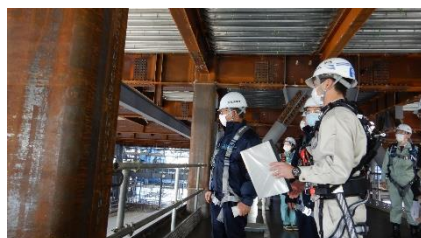
吹き抜け部分の墜落防止対策を点検しました。
