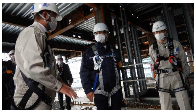
清水支店長からデッキスラブの崩壊防止等の説明を受ける小林局長。
