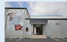
水産加工工場外観 (女川町)
