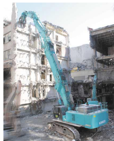
特定解体用機械のコンクリート圧碎機 コベルコ建機株式会社製、同社提供
