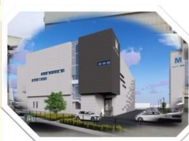
本社・物流センター 2025年11月完成
