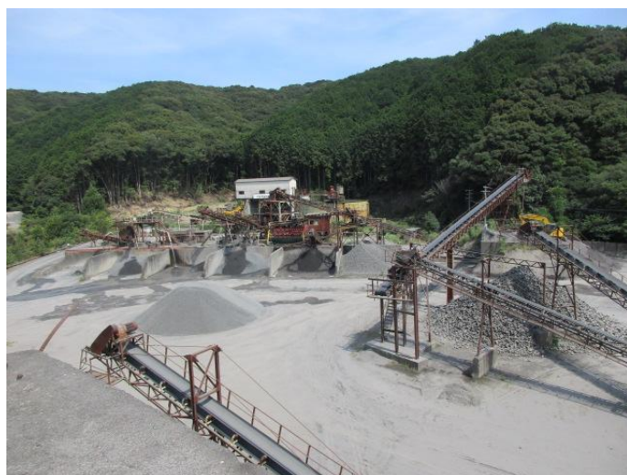
↑今回パトロールさせていただいた 有限会社出馬重機 神津佐第二採石工場
