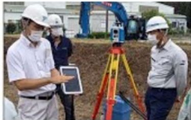
UAVによる起工測量研修
