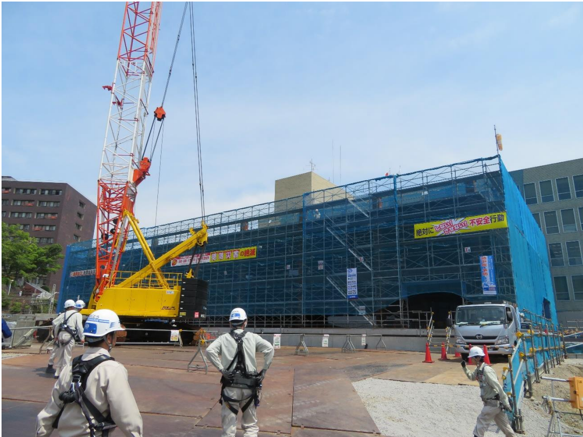
パトロールの実施現場
