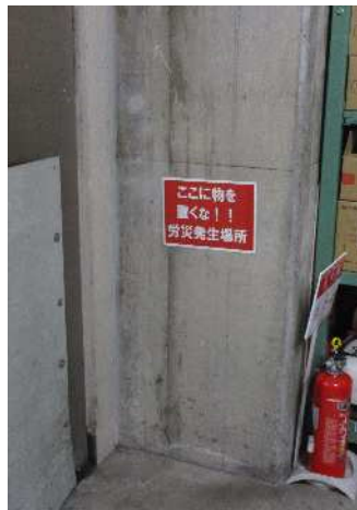
労災事故発生場所の明示
