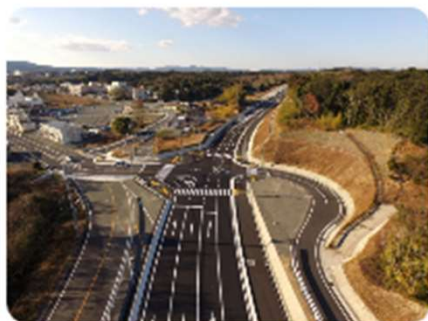
H28 167号(鵜方磯部BP)道路改良工事(その5)
