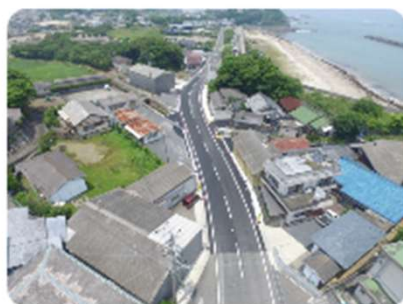
H28磯部大王線(甲賀)道路改良工事
