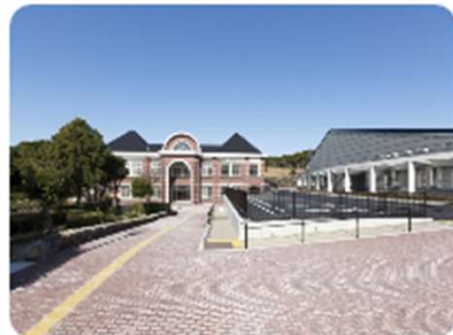
市立図書館大規模改修工事(建築工事)
