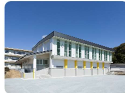
磯部小学校屋内運動場
