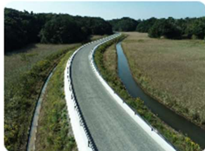
主要地方道磯部大王線(志島BP・甲賀)道路改良工事
