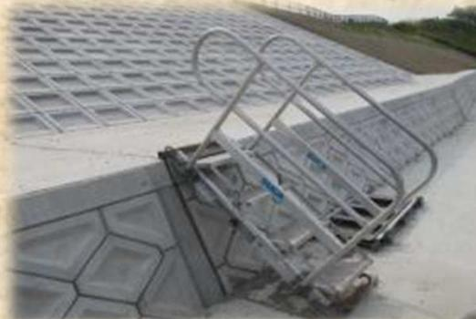
護岸工として堤防に張ブロックを設置しているが、わずかな段差においても飛び降りやよじ登りをしないよう昇降設備を設置している。
