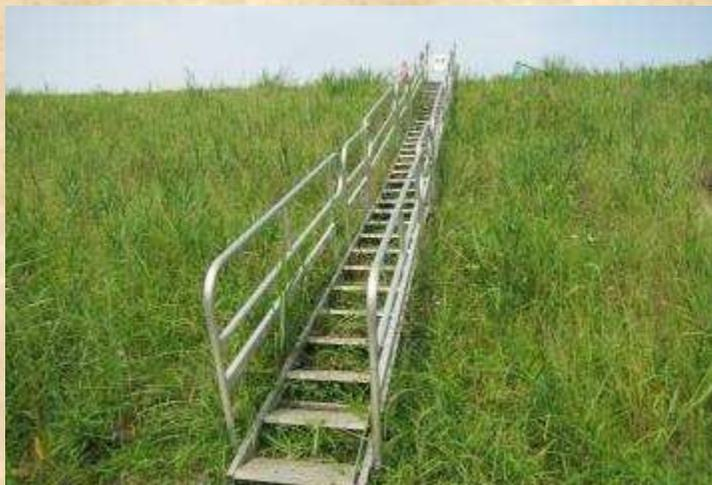
堤防の内外および堤防上で工事があるため堤防を昇降することが多い。草の上は雨の日などは非常に滑りやすいため仮設の昇降階段を設置した。
