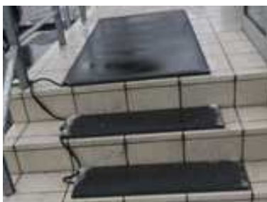
屋外通路・階段踏面に融雪マットを設置
