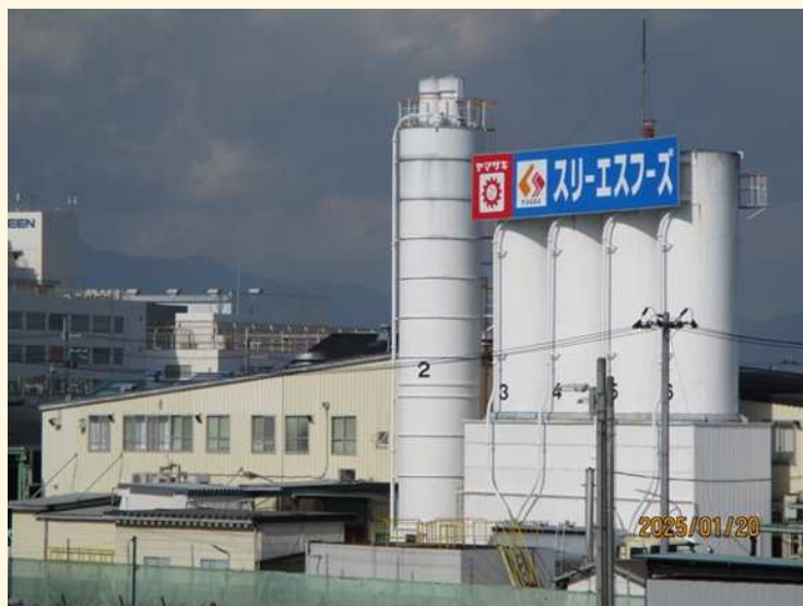
株式会社スリーエスフーズ様 工場外観
