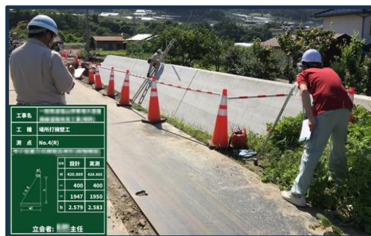
↑「電子小黒板ソフト」使用状況 （作業員が現場で実際に黒板を持つことなく、同様の撮影ができる）
