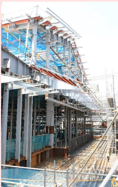
▲ 舞台部分の鉄骨組立が進む 歌舞練場棟
