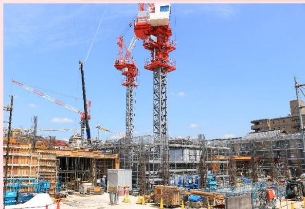
▲ 鉄筋・型枠工事が行われる ホテル棟
