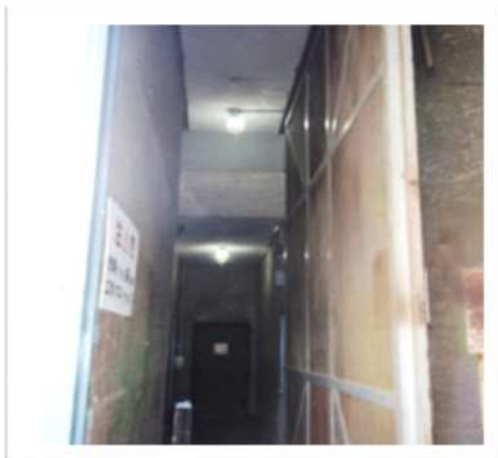
転倒災害防止のため、通路に照明を増設した
