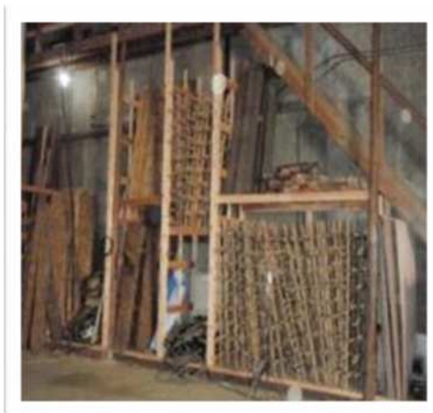
用具・材料を床に置き、つまずいて転倒する危険があったため、棚を設置して整理した
