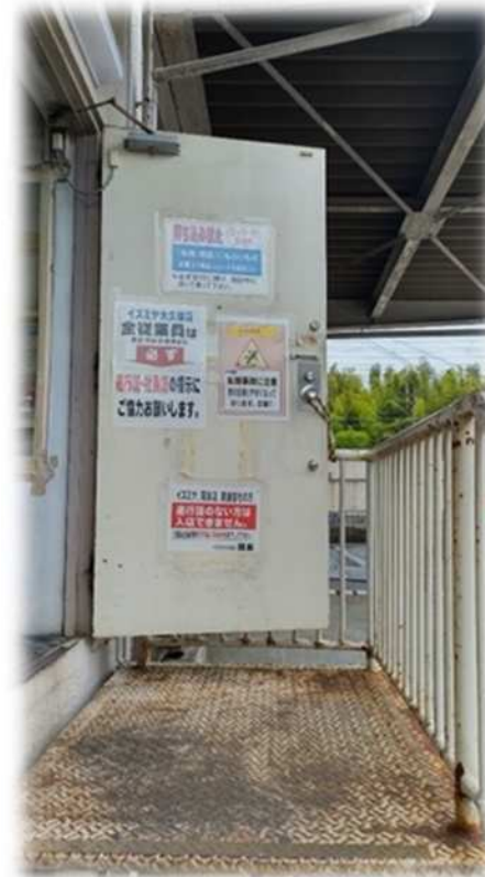
出入口、スロープ にPOP掲示
